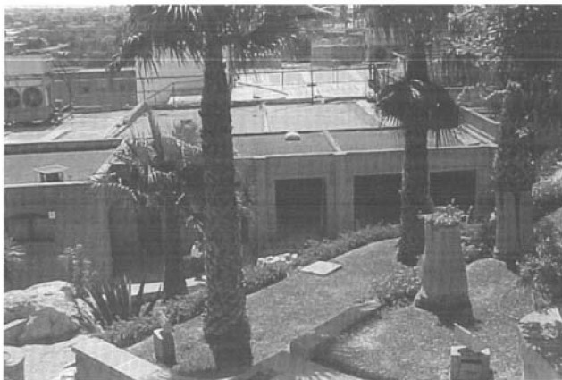
Así lucen las bodegas después de la restauración.
