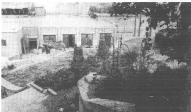
Las bodegas fueron reconstruidas para baños, sala de espera, refectorios y dirección.
