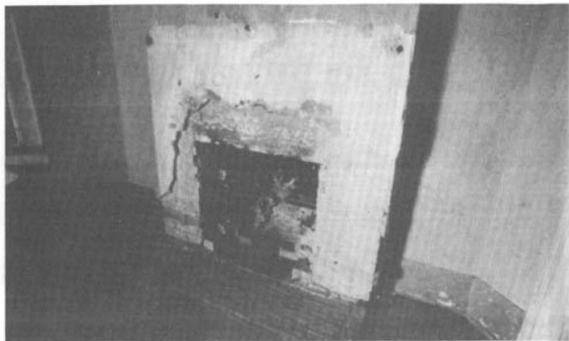
Aquí se encontraba la chimenea.
