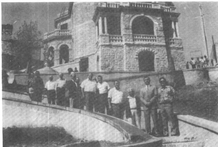
En plena restauración de los interiores, pues el exterior estaba totalmente restaurado con sus barandales, balaustradas, pilares y remates. Puede observarse la limpieza del edificio. En la foto aparecen de izquierda a derecha del lector: Lic. Armando Martínez Herrera, Ing. Héctor Ballesteros Lozano, Manuel González García, Hernán Cepeda Cepeda, Lic. Jorge Argüeyo Aceves, Felipe Rodríguez Macías, Carlos Cepeda Cepeda, Lic. Homero H. del Bosque Garza, Carlos Jalife García, Lic. Homero H. del Bosque Villarrival, Lic. Carlos Román Cepeda González y Arq. Miguel H. Ruiz Castro.
